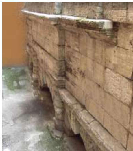
Resti dell'Acquedotto romano dell'Acqua Vergine al Nazareno
